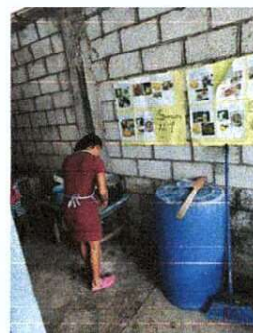
Foto 4: 1. Sustitucion de estufa rural completa y Mejoramiento de muro y puerta de metal con sistema de despacho de alimentos en cocica
