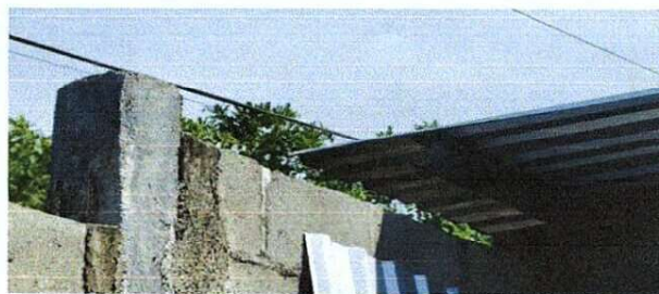
Foto 9: Mejoramiento de canal
