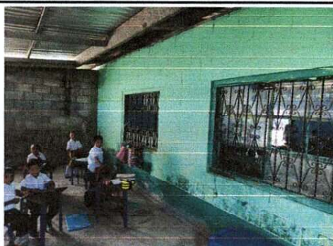
Foto 3: Mejoramiento y levantado de muro a dintel en ventana
