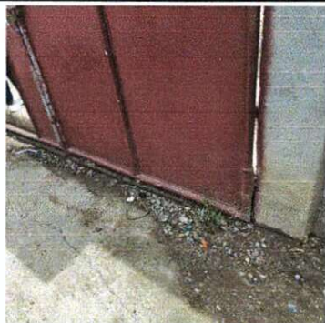
Foto 6: Mejoramiento de losa de patio en ingreso principal
