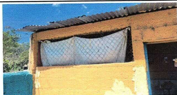
Foto 3: SUSTITUCIÓN DE BALCONES
