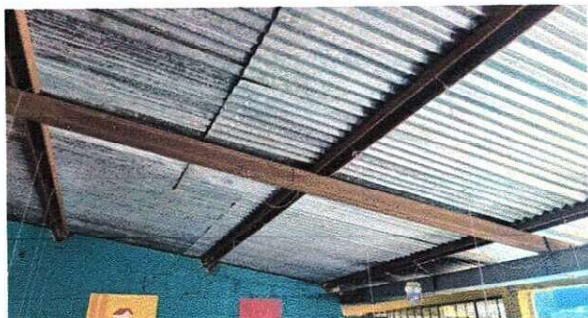
Foto1: SUSTITUCIÓN DE LÁMINA, POR LAMINA TROQUELADA ALUZING CALIBRE 26
