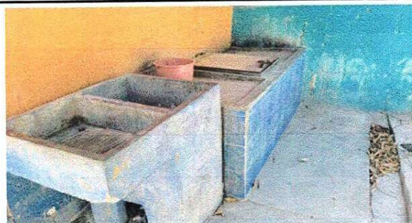
Foto 6: SUSTITUCIÓN DE PILA
