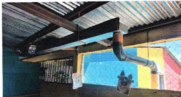
Foto 2: SUSTITUCIÓN DE CANAL METÁLICO
