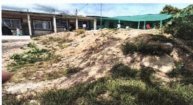
Foto 1: MEJORAMIENTO MURO DE CONTENCIÓN
