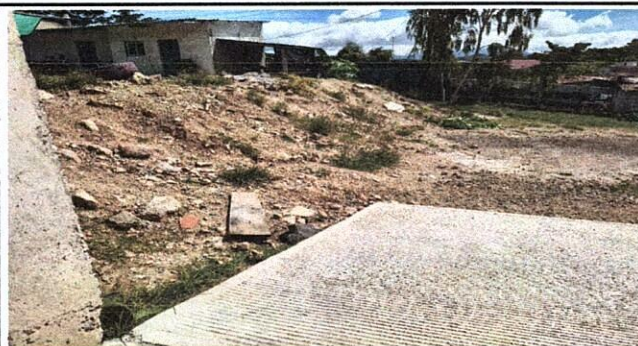
Foto 2: MEJORAMIENTO DE MURO DE BLOCK
