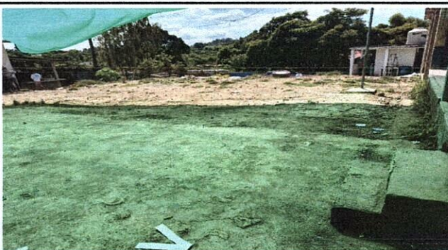
Foto 3: MEJORAMIENTO PISO DE CONCRETO
