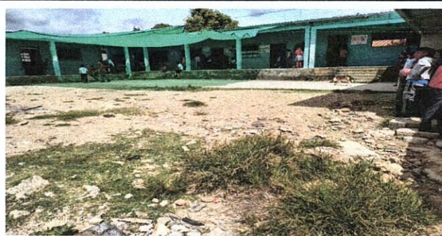
Foto 5: MEJORAMIENTO DE MAYA+TUBO GALVANIZADO
