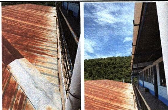
Foto 3: Sustitución de canales de pvc por canales de metal.
