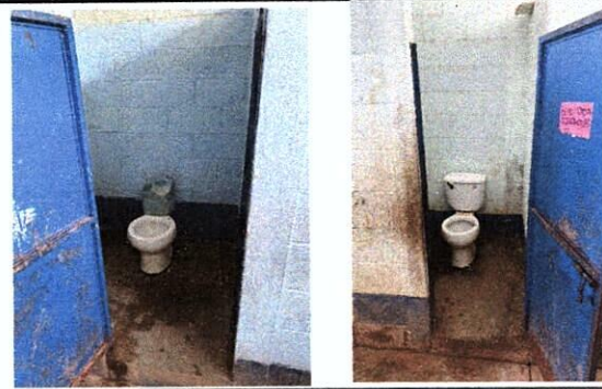
Foto 4: sustitución de 6 inodoros.
