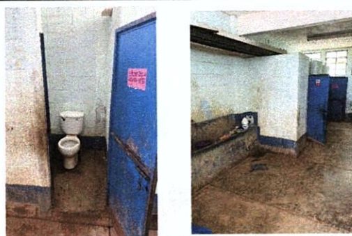
Foto 6: Reparación y sustitución de azulejo en módulos de sanitarios.
