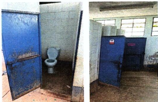
Foto1: Mantenimiento a estructura de 6 puertas de sanitarios
