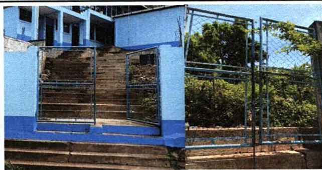
Foto 5: Mantenimiento a portones de metal.
