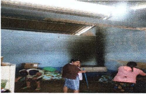
Foto1: MEJORAMIENTO DE REPELLO EN MUROS DE COCINA 1
