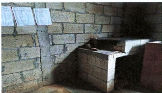
Foto 9: SUSTITUCIÓN Y AMPLIACIÓN DE MESA DE ESTUFA RURAL COCINA 2
