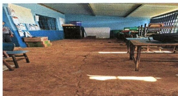
Foto 10: MEJORAMIENTO DE BASE PARA PISO Y PISO CERAMICO EN EL CORREDOR DEL AREA DE PREPRIMARIA
