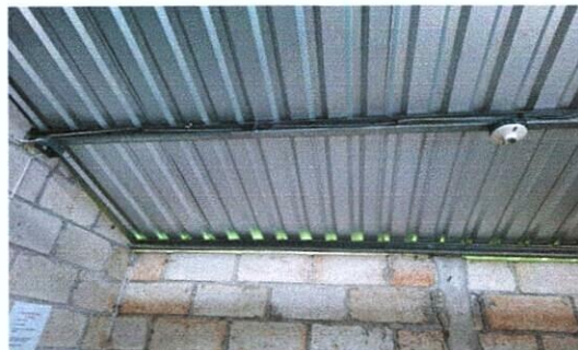
Foto 8: MEJORAMIENTO DE INSTALACION ELECTRICA COCINA 2 y aulas 1 y 2
