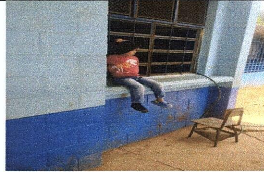
Foto 4: MEJORAMIENTO DE VENTANA TIPO PERSIANA EN COCINA 1
