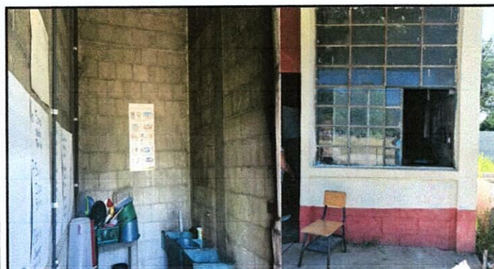
Foto 3: MEJORAMIENTO DE REPELLO EN MUROS DE COCINA, BODEGA Y MEJORAMIENTO DE PINTURA EN MUROS Y SUSTITUCIÓN DE VENTANA TIPO PERSIANA
