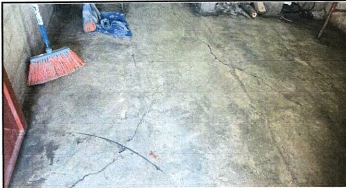
Foto 2: MEJORAMIENTO DE BASE PARA PISO CERÁMICO EN COCINA Y SUSTITUCIÓN DE PISO CERÁMICO EN COCINA Y BODEGA
