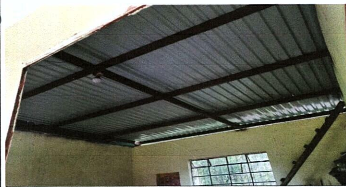
Foto 5: MEJORAMIENTO DE INSTALACIONES ELÉCTRICAS
