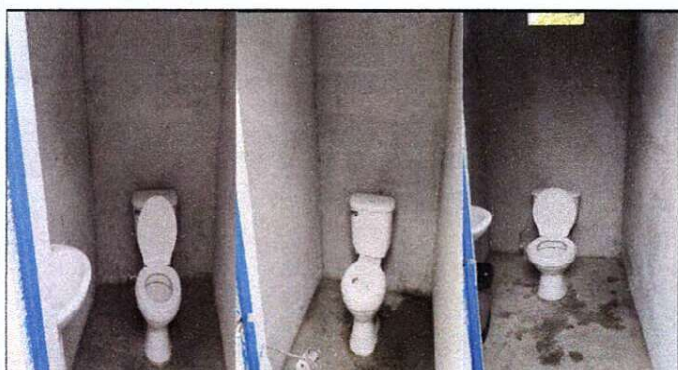
Foto 3: Sustitución de piso cerámico Baños Y Sustitución de Azulejo baños Y Pintura en muros interiores baños.
