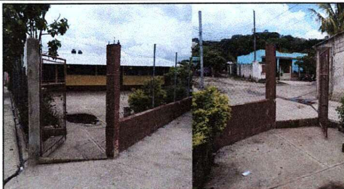
Foto 2: Mejoramiento y Mantenimiento a portones de metal, Sustitución de lámparas Y Repello en muro Y Pintura en muros exteriores e interiores
