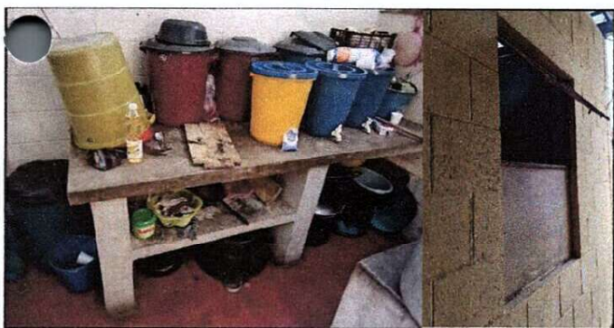
Foto 5: Sustitución de piso cerámico Cocina y Mejoramiento de Ventana de metal en Cocina.
