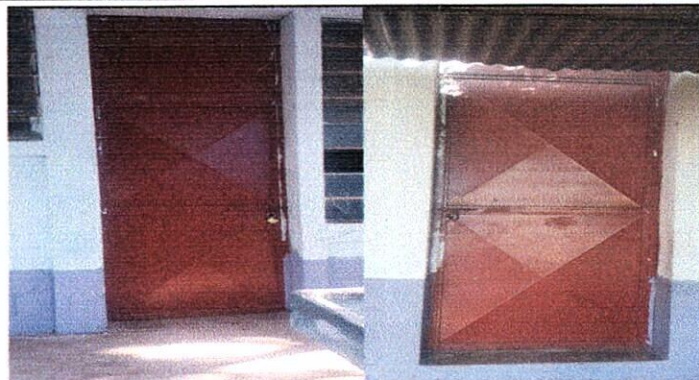
Foto 2:Mantenimiento a estructura (lijado, cambio de tubo , cepillado, sujeciones, aplicación de pintura), Sustitución de chapa puertas de bodega y cocina
