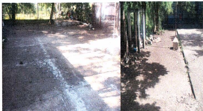
Foto 3: Reparación de planchas de concreto de patio
