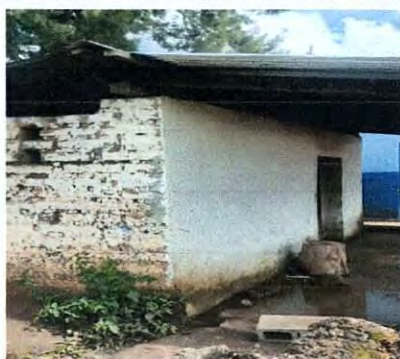
Foto: Mejoramiento, refuerzo de paredes con columnas, levantado y repello total
