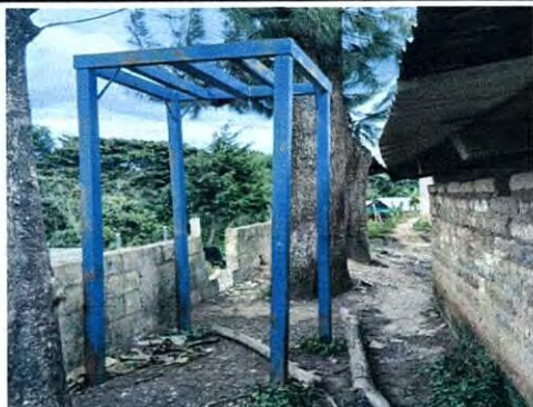
Foto: Mejoramiento y sustitución de deposito de agua de 1,100 litros
