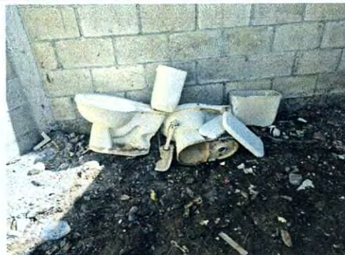
Sustitucion y mejoramiento de area de baños
