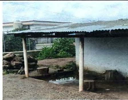
Foto: Mejoramiento de piso de torta de concreto
