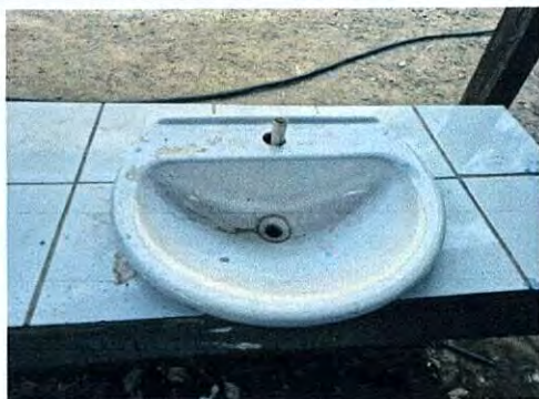
Sustitución y mejoramiento de area de lavamanos
