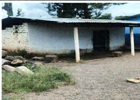
Foto: Sustitucion de vigas, costaneras y laminas
