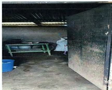
Foto: Mantenimiento de puertas, reparación, lijado y pintado
