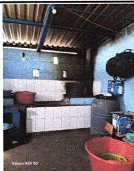
Foto1: MEJORAMIENTO DEL AREA DE COCINA (SUSTITUCIÓN DE LÁMINA Y ESTRUCTURA METÁLICA).
