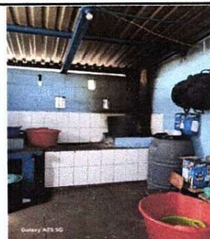
Foto 10: SUSTITUCIÓN DE ESTUFA RURAL CON CHIMENEA, PLANCHA DE METAL MÁS INSTALACIÓN DE AZULEJO, MUEBLE DE COCINA Y MEJORAMIENTO DE PAREDES EN ÁREA DE COCINA
