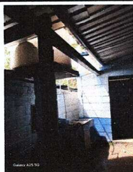
Foto 2: MEJORAMIENTO DE TECHO CON INSTALACIÓN DE CANAL METALICO CON BAJADAS DE AGUA PLUVIAL
