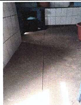
Foto 4: SUSTITUCIÓN DE PISO DE TORTA DE CONCRETO POR PISO CERÁMICO EN COCINA Y AULA
