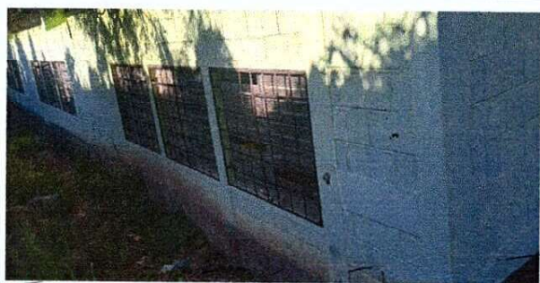
Foto1: Reparacion de muros de aula a block mampuesto
