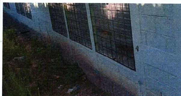
Foto 4: Reparacion de muros de aula
