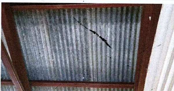
Foto 3: Instalacion de lamina troquelada aluzinc
