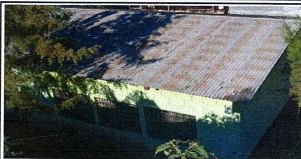
Foto 2: Sustitucion de estructura de metal mas cubierta de techo de lamina de aluzinc tipo troquelada
