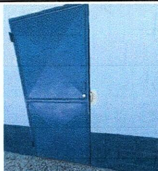
Foto 10: MANTENIMIENTO A ESTRUCTURA (LIJADO, CEPILLADO, SUJECCIONES, APLICACIÓN DE PINTURA) Y CAMBIO DE CHAPA EN PUERTA.
