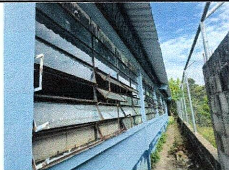
Foto 6: SUSTITUCIÓN DE VENTANALES POR VENTANAS CORREDIZAS DE PVC COLOR BLANCO DE 3.5 X 1.15 MT. Y MEJORAMIENTO A ESTRUCTURA Y PINTURA DE BALCONES METÁLICO
