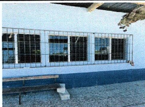
Foto 9: MEJORAMIENTO DE BALCONES METÁLICOS CON APLICACIÓN DE PINTURA.
