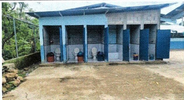
Foto 11: MEJORAMIENTO DE SERVICIOS SANITARIOS
