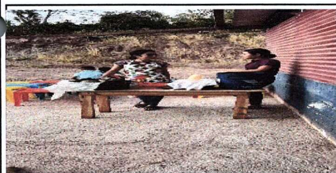
Foto 5: Mejoramiento de piso
