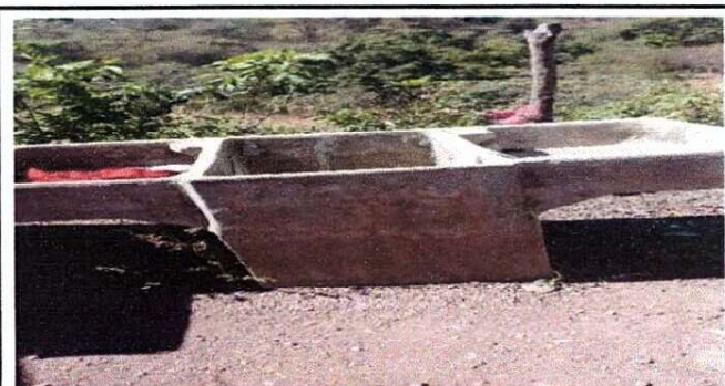
Foto 4: Mejoramiento de pila
