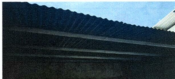
Foto 2: SUSTITUCIÓN DE LÁMINA POR LAMINA TROQUELADA CAL. 26
