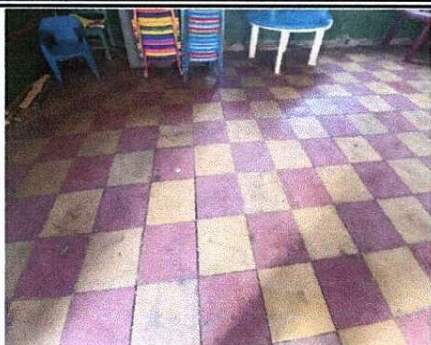
Foto 1: SUSTITUCIÓN DE PISO
