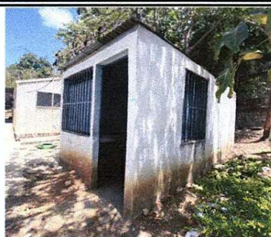
Foto 2: PINTURA INTERIOR Y EXTERIOR DE COCINA
