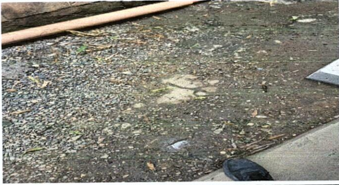
REPARACION DE PLANCHA DE CONCRETO PARA PATIO
