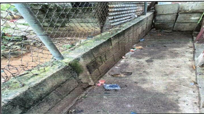
SUSTITUCION DE MALLA POR MURO DE BLOCK
