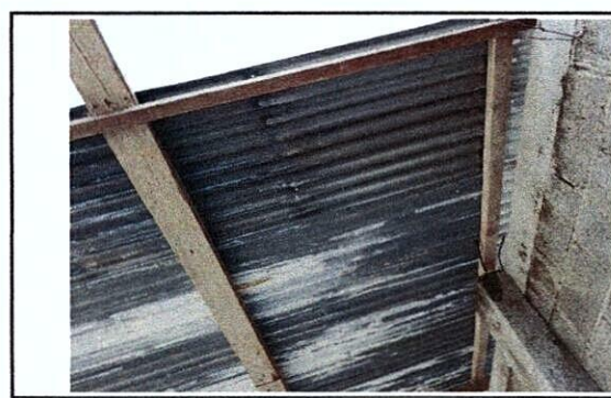
Foto 6: Instalación de unidades y armado superior
