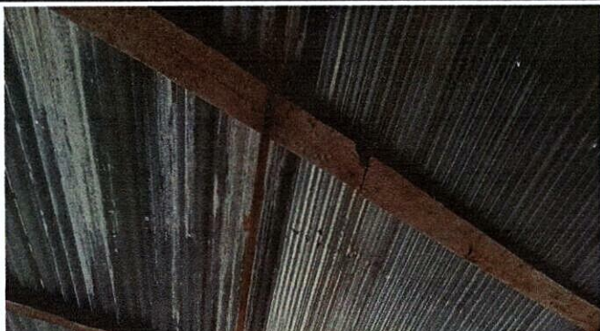
Foto 1: Sustitución, corte he Instalación de Láminas acanaladas legítimas calibre 28, Sustitución de capote de lámina para lámina acanalada e Instalación de Capotes acabado final
