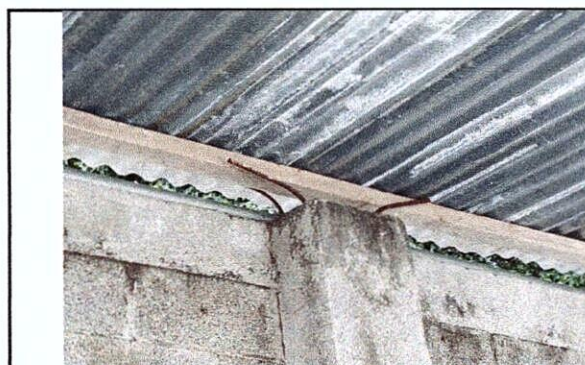
Foto 4: Sustitución de estructura de madera por armado y soldado de estructura de metal legítimo (tijera)
