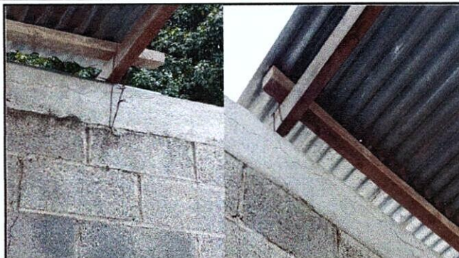
Foto 2: Sustitución de estructura de soporte de madera por armado, soldado y pernado de
