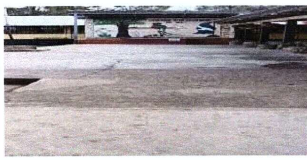
Foto 4: Reparación de losa de concreto en patio
