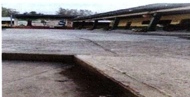
Foto 3: Reparación de losa de concreto en patio
