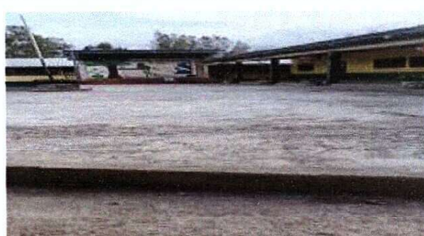
Foto 2: Reparación de losa de concreto en patio
