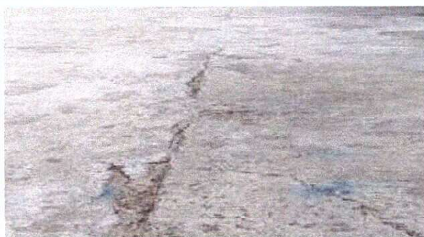
Foto 1: Reparación de losa de concreto en patio
