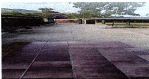
Foto 5: Reparación de losa de concreto en patio
