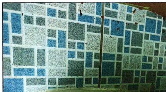
Foto 4: Mejoramiento de piso antideslizante
