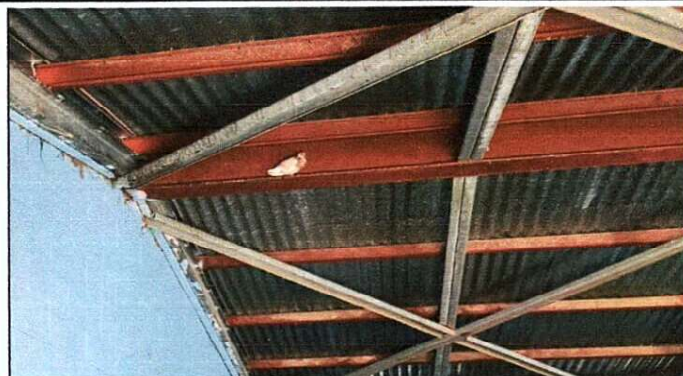
Foto 2: Mantenimiento de estructura de techo
