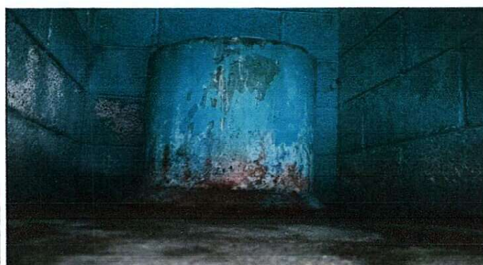
Foto 3: Sustitución de inodoros
