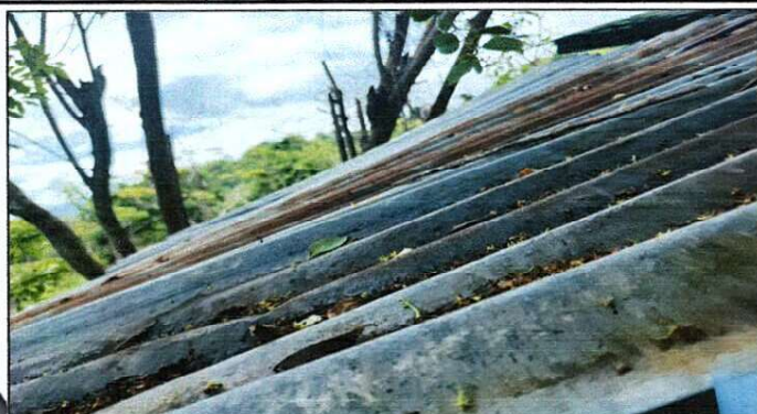
Foto1: Sustitución de lamina por lamina aluzinc calibre 26
