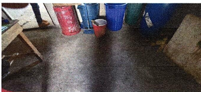
Foto 2: MEJORAMIENTO DE PISO CERÁMICO
