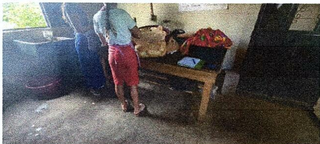
Foto 1: MEJORAMIENTO DE MESA DE CONCRETO
