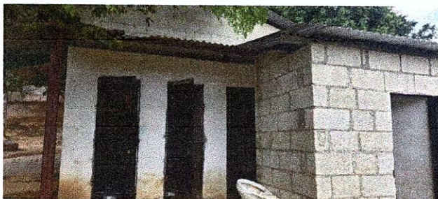
Foto 5: SUSTITUCIÓN DE PUERTA METÁLICAS
