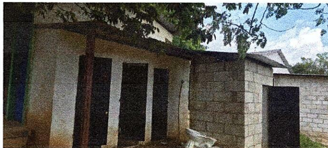
Foto 4: SUSTITUCIÓN DE TECHO DE LÁMINA
