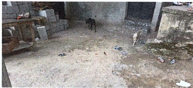
Foto 6: MEJORAMIENTO DE PISO DE CONCRETO
