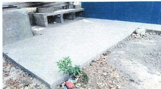
Foto 2: SUSTITUCIÓN DE PISO CERÁMICO
