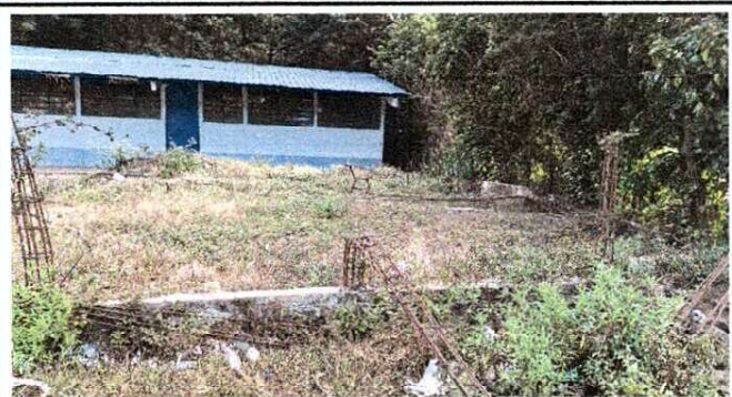
Foto 5: Cimientos y columnas
