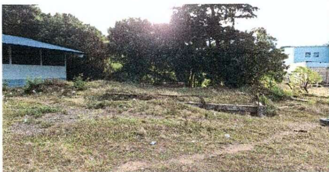
Foto 3: Parte lateral del cimiento para el levantado de paredes
