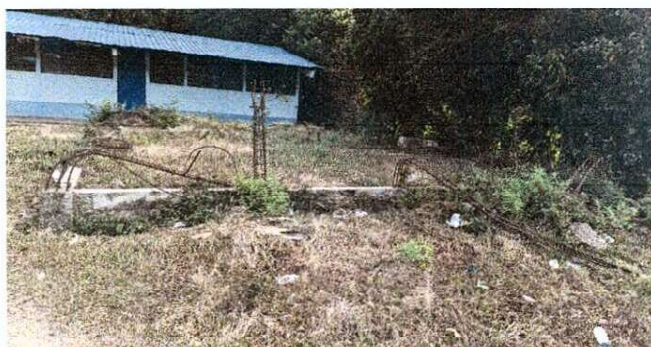
Foto 1: Muestra el área de levantado de paredes del establecimiento parte frontal
