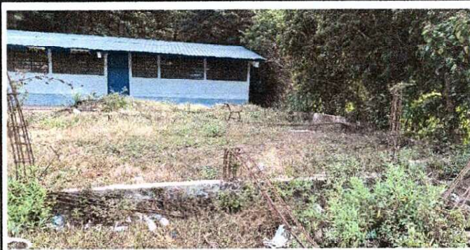
Foto 2: Se muestra el área de cimientos del aula a trabajar parte frontal
