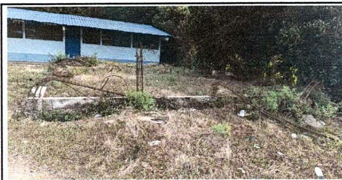
Foto 4: Parte de enfrente de cimientos
