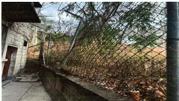
Foto 5: Sustitución de muro perimetral
