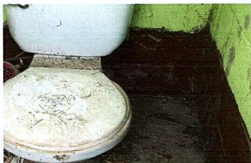
Foto 3: Sustitución de sanitario
