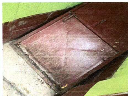
Foto 4: Reparación de puerta de sanitario
