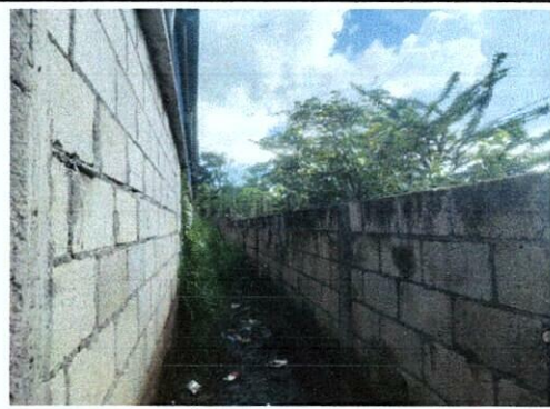
Foto 4: Mejoramiento de muro perimetral de block
