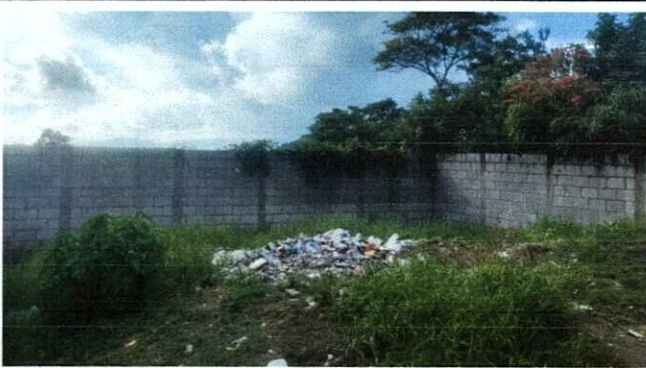
Foto 3: Mejoramiento cerco tipo razor a hilada circular con alambre galvanizado sobre muro perimetral de block
