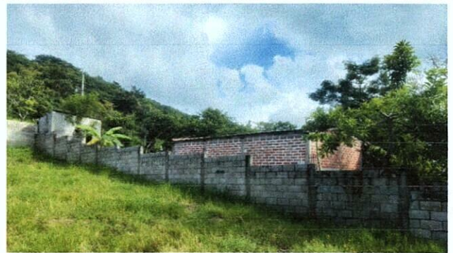
Foto 2: Mejoramiento de muro perimetral de block
