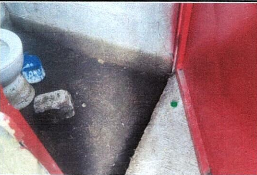
Foto 5: Losa de concreto para piso
