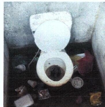
Foto 6: Sustitución de inodoro
