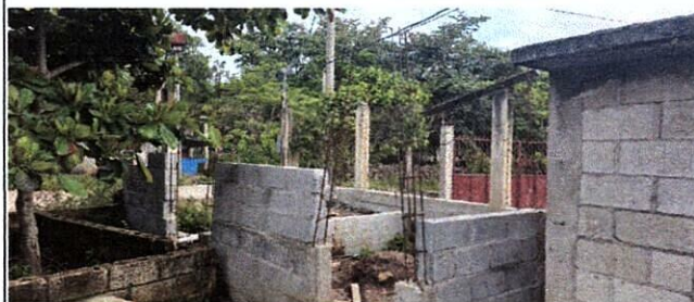
Foto 6: Mejoraiento de muros
