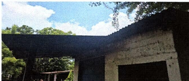
Foto 2: Mejoramiento de cubierta de lámina troquelada aluzinc calibre 26
