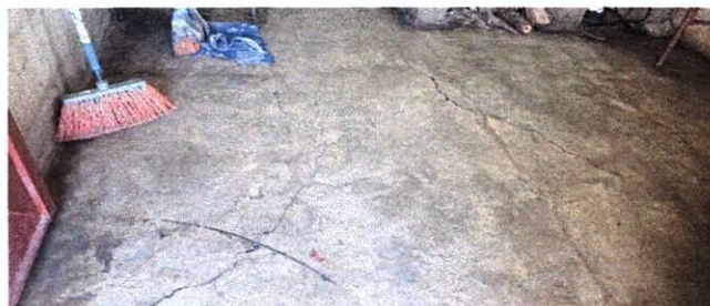
Foto 4: SUSTITUCIÓN DE PISO DE CONCRETO
