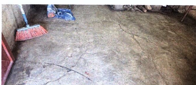
Foto 4: SUSTITUCIÓN DE PISO DE CONCRETO
