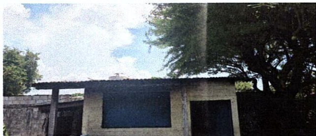
Foto 1: Mejoramiento de cubierta de lámina troquelada aluzinc calibre 26 y ventanería
