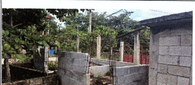
Foto 6: Mejoraiento de muros
