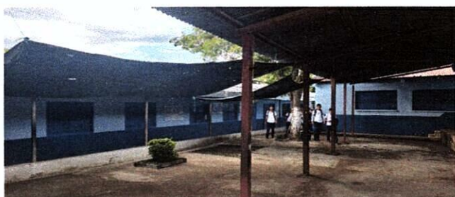
Foto 3: Mejoramiento de cubierta de lámina troquelada aluzinc calibre 26
