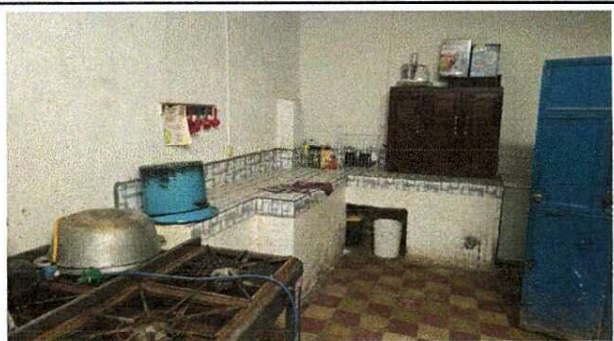
Foto 1: MEJORAMIENTO DEL AREA DE COCINA ( PAREDES DE BLICK, REPELLO Y CERNIDO, SUSTITUCIÓN DE PISO, MEJORAMIENTO DE PILA, INSTALACIÓN DE VENTANA, MEJORAMIENTO DE PUERTA METALICA, MEJORAMIENTO DE MUEBLE DE COCINA, REPACIÓN Y MEJORAMIENTO DEL SISTEMA ELECTRICO).
