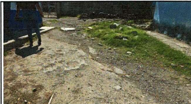
Foto 6: REPARACIÓN DE PISO DE CONCRETO
