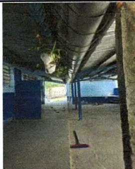
Foto 8: MEJORAMIENTO DE CANALES Y BAJADAS DE AGUA PLUVIAL CON COLUMNAS DE CONCRETO, TUBO PVC Y SUSTITUCIÓN DE REPOSADERAS
