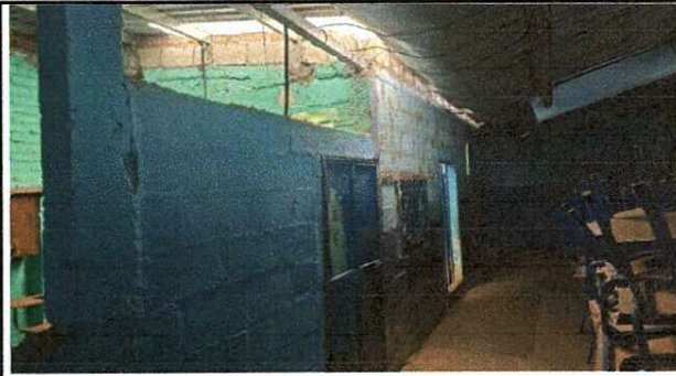
Foto 2: MEJORAMIENTO DEL AREA DE COCINA ( PAREDES DE BLICK, REPELLO Y CERNIDO, SUSTITUCIÓN DE PISO, MEJORAMIENTO DE PILA, INSTALACIÓN DE VENTANA, MEJORAMIENTO DE PUERTA METALICA, MEJORAMIENTO DE MUEBLE DE COCINA, REPACIÓN Y MEJORAMIENTO DEL SISTEMA ELECTRICO).
