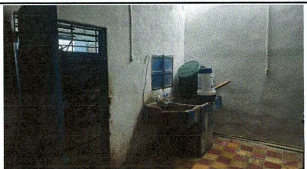
Foto 3: MEJORAMIENTO DEL AREA DE COCINA ( PAREDES DE BLICK, REPELLO Y CERNIDO, SUSTITUCIÓN DE PISO, MEJORAMIENTO DE PILA, INSTALACIÓN DE VENTANA, MEJORAMIENTO DE PUERTA METALICA, MEJORAMIENTO DE MUEBLE DE COCINA, REPACIÓN Y MEJORAMIENTO DEL SISTEMA ELECTRICO).
