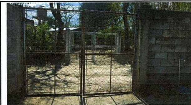
Foto 4: MEJORAMIENTO DE PORTÓN METALICO DE INGRESO AL CENTRO EDUCATIVO
