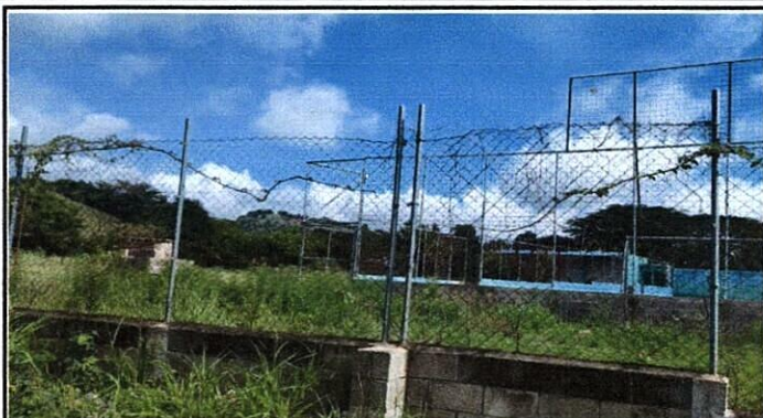
Foto 1: Mejoramiento de muro perimetral
