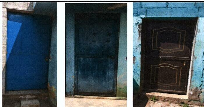
Foto 6: mantenimiento de puertas (cepillado y pintura) y cambio de chapas
