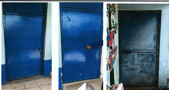
Foto 5: Mantenimiento de puertas (cepillado y pintura) y cambio de chapa
