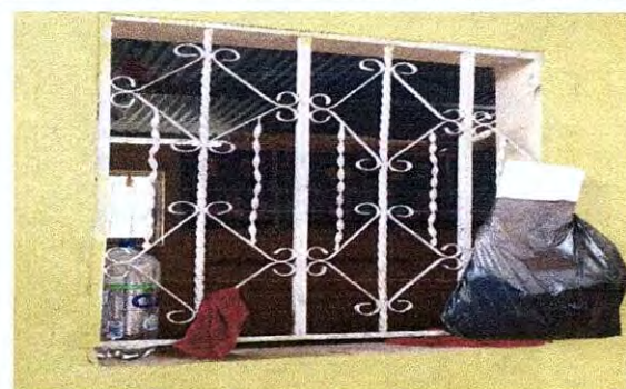
Foto 4: Instalación de ventana de PVC No. 1
