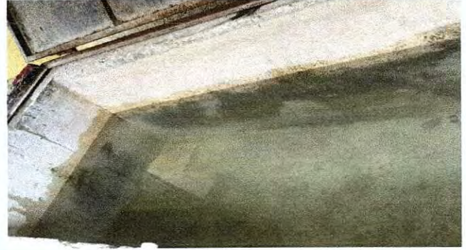
Foto 20: instalacion de azulejo en interior completo en pila de lavado.
