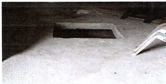
Foto13: Instalacion de piso cerámico en área de Dirección.
