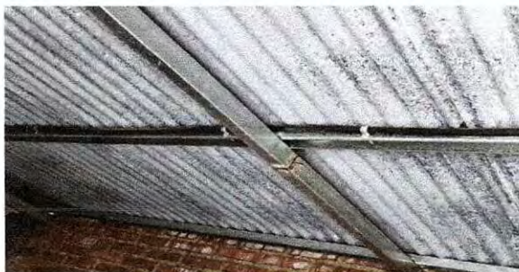
Foto 15: Instalación de energía eléctrica en área de Dirección
