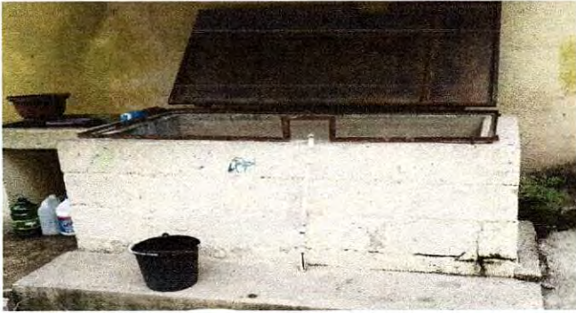
Foto19: Elaboracion de repello total gris y blanco en pila de lavado.
