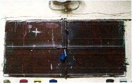
Foto 8: Instalación de ventana PVC No. 5
