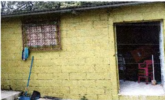
Foto 11: . Repello total en pared interior y exterior gris y blanco.
