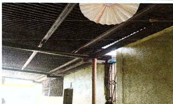
Foto 3: sustitución de canales y bajadas de agua en techo de módulo 1 completo.
