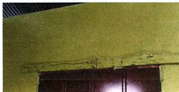
Foto 18: Reforzamiento de linteles y columnas en ventanas.
