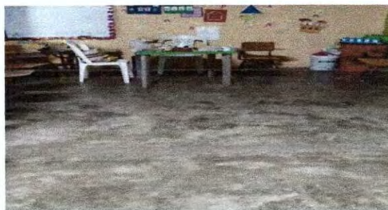
Foto 16: Instalación de piso cerámico en área de salón completo.
