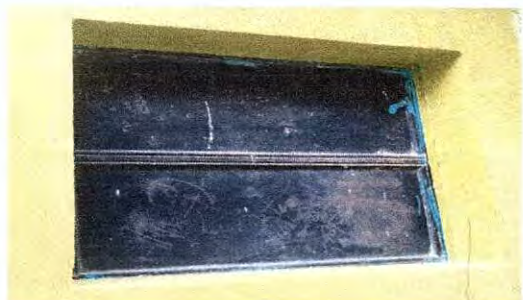
Foto 5: Instalación de ventana de PVC No. 2
