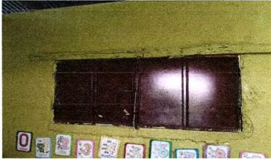
Foto 7: Instalación de ventana PVC No. 4
