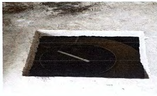
Foto 14: Instalación de tapadera para cisterna
