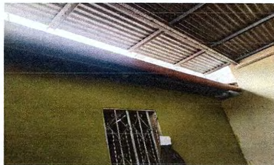
Foto 2: sustitución de canales y bajadas de agua en techo de módulo 1 completo.
