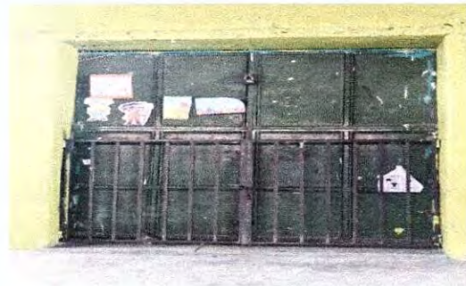
Foto 10: Instalación de portón de metal principal en salón.
