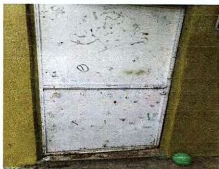
Foto 1: Mantenimiento de Puerta de metal, sustituyendo óxido, lijado y pintado.
