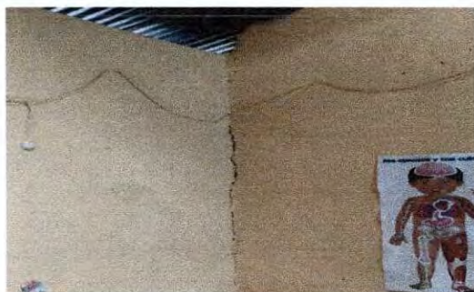
Foto 17: Eliminación e instalación de columna para grietas en aula salón.
