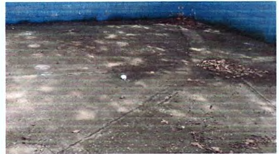
Foto 6: ELABORACIÓN DE DRENAJE Y REPOSADERO
