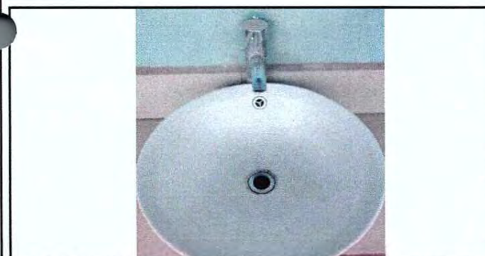
Foto 5: Mejormiento de lavamanos fundidos en concreto con servicio de agua y drenaje
