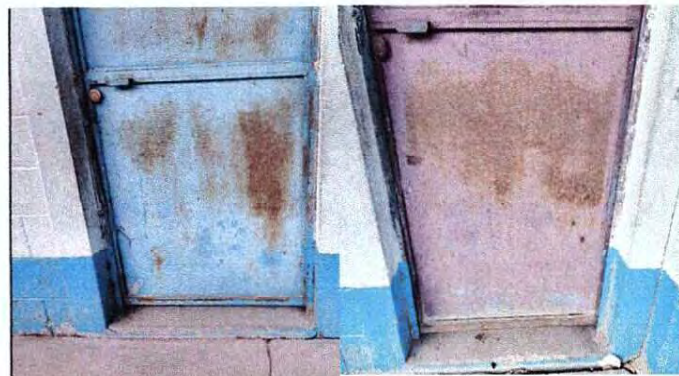
Foto 4: Mantenimiento de puertas, cambio de tubos dañados, lijado cepillado, instalacion de chapa nueva y dos manos de pintura anticorrosiva azul. Mantenimiento de puertas, lijado cepillado, dos
