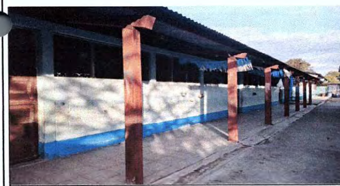
Foto 11: Mejoramiento postes metálicos de corredor principal de Lijado y pintura
