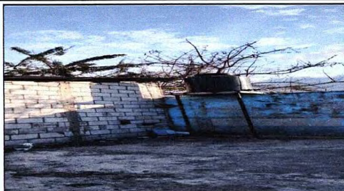
Foto 2: Mejoramienot e Instalacion de tinaco con instalacion superficial a servicios. Mantenimiento de puertas, reparación, lijado, cepillado, dos manos de pintura anticorrosiva azul
