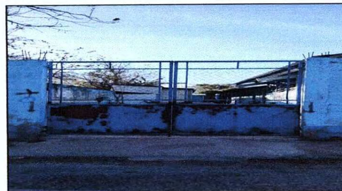
Foto 10: Mejoramiento de portón principal reemplazo de malla por lámina, lijado y pintado, medidas de 3.25 de alto por 2.90 m de ancho
