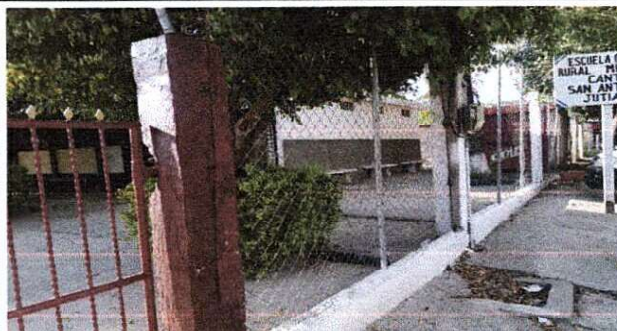
Foto 2: MEJORAMIENTO MURO PERIMETRAL
