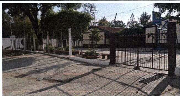
Foto 1: MEJORAMIENTO MURO PERIMETRAL
