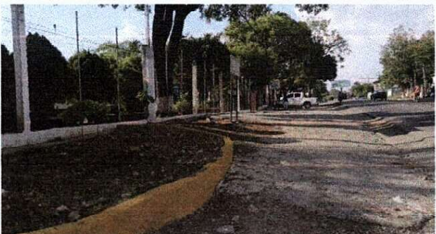
Foto 3: MEJORAMIENTO MURO PERIMETRAL
