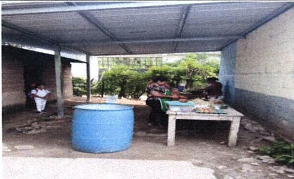
Foto 1: MEJORAMIENTO TECHO DE LAMINA EN COCINA
