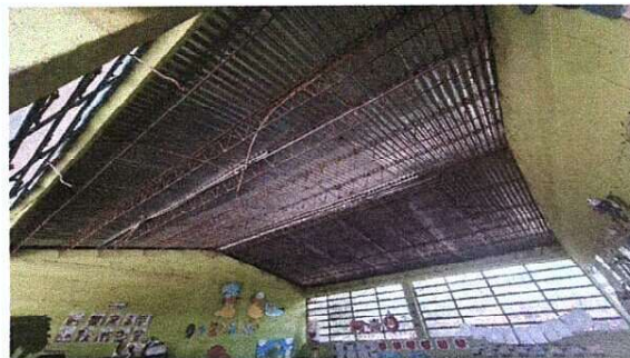
Foto 2: Área a trabajar: Mantenimiento a estructura de soporte de metal y reparación de sistema eléctrico.
