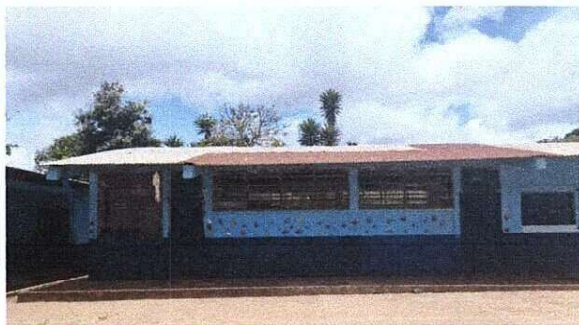
Foto1: Área a trabajar, sustitución de lámina, por lámina troquelada aluzinc calibre 26, sustitución de capote, sustitución de elementos de fijación, en las aulas de la EODP Anexa a EORM El Durazno.
