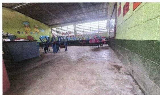
Foto 4: Área a trabajar: sustitución de piso cerámico, pintura en muros exteriores e interiores.
