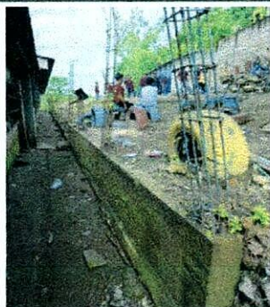
Foto 3: MEJORAMIENTO DE MURO DIVISORIO
