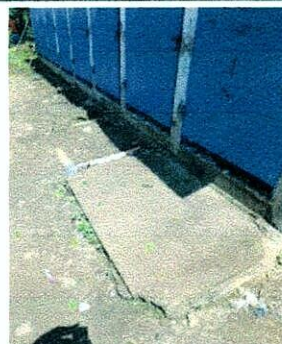
Foto 4: MEJORAMIENTO DE PISO DE TORTA DE CONCRETO EN SERVICIOS SANITARIOS
