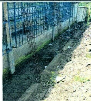
Foto 2: MEJORAMIENTO DE MURO DIVISORIO
