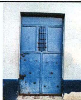
Foto 4: Mantenimiento de puerta pintura general
