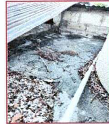
FOTO 8: Impermeabilización de terraza de baños por filtración de agua mas reparación de pañuelos (foto insertada)
