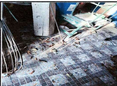
Foto 5: Sustitucion de piso por piso antideslizante en area de servicios sanitarios mas sustitucion de inodoro (imagen insertada)
