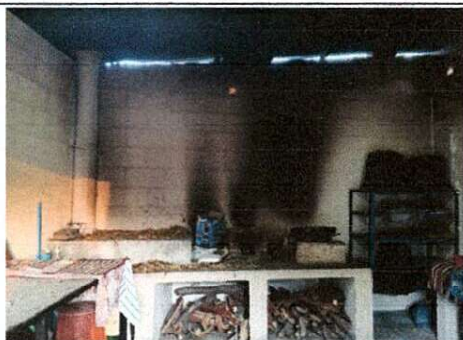
Foto 1: Sustitucion de estufa rural completa y reparacion de mueble de cocina
