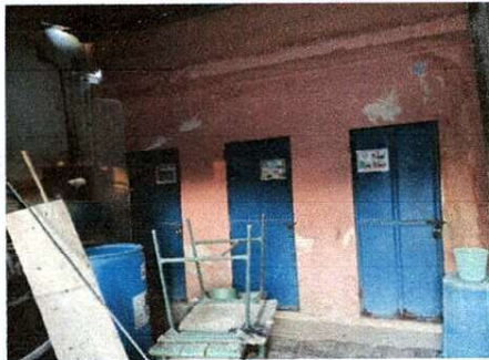
FOTO 7: Mantenimiento de Puertas pintura general. Reparación de Sanitarios, (Cambio de 1 en mal estado, pintura de 4 puertas, reparación de lavamanos, instalación de drenaje, mas instalación de pila existente, detalle foto 2 )
