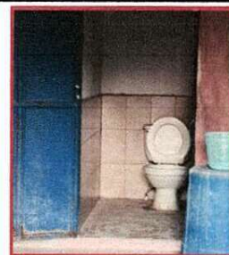
Foto 6: Sustitución de baño en mal estado, reposadera y lavamanos
