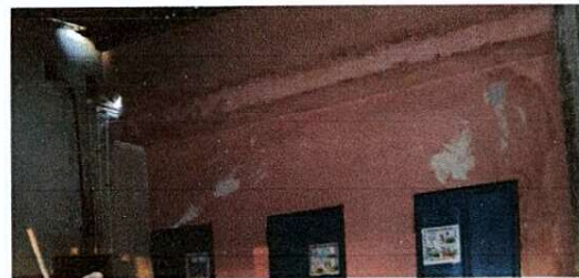
Reparación de Sanitarios, (Cambio de 1 en mal estado, pintura de 4 puertas, instalación de lavamanos, instalación de reposadera, instalación de pila )
