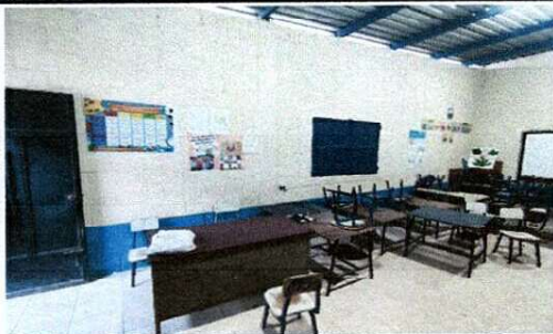
FOTO 9: Apertura a corte de ventana sillar y dintel para ventana mas fabricación e instalación de ventana de metal
