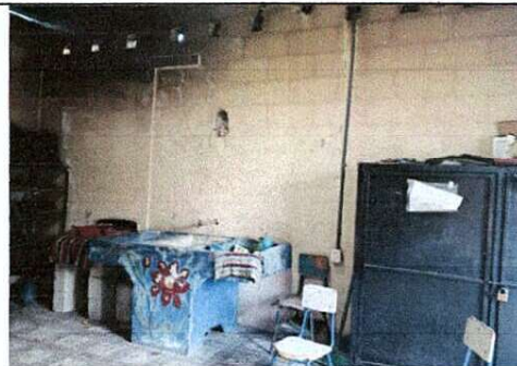
Foto 2: Continúa reparación de mueble de cocina y la pila se traslada al área de servicio sanitarios con su instalacion incluida mas drenaje
