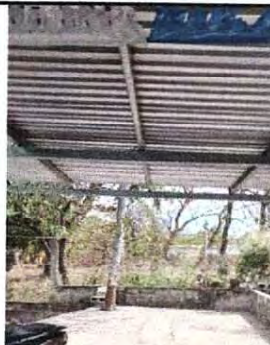
Foto 2: MEJORAMIENTO DE TECHO DE LAMINA CON ESTRUCTURA DE METAL EN MODULO DE AULAS Y PATIO
