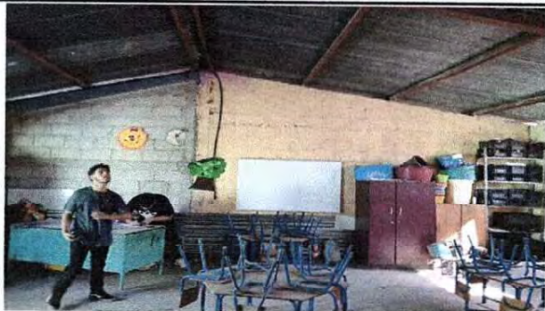
Foto 7: REPARACIÓN DEL SISTEMA ELECTRICO
