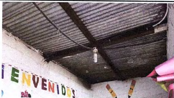
Foto1: MEJORAMIENTO DE TECHO DE LAMINA CON ESTRUCTURA DE METAL EN MODULO DE AULAS Y PATIO
