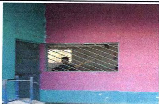
Foto 11: MEJORAMIENTO DE VENTANA
