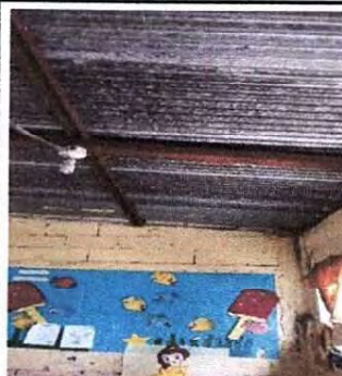
Foto 2: MEJORAMIENTO DE TECHO DE LAMINA CON ESTRUCTURA DE METAL EN MODULO DE AULAS Y PATIO
