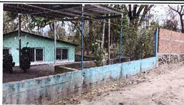
Foto 8: MEJORAMIENTO DE MURO PERIMETRAL
