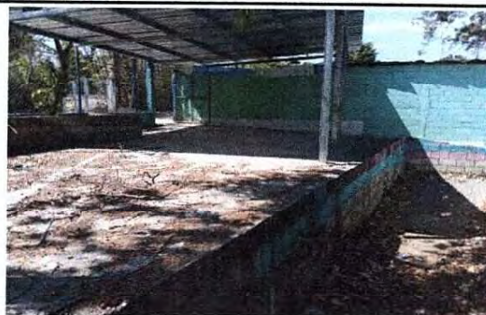
Foto 4: MEJORAMIENTO DE PAREDES DE BLOCK Y COLUMNAS
