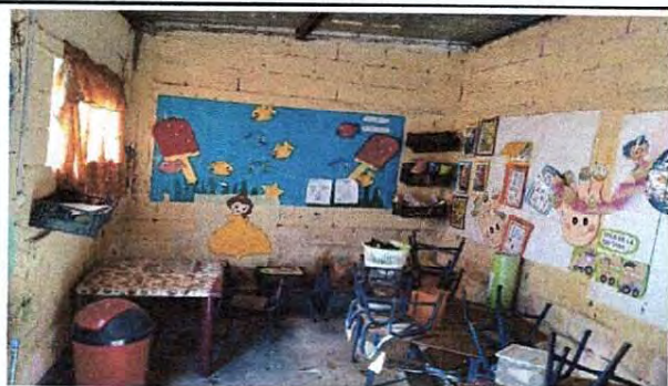
Foto 3: MEJORAMIENTO DE DE PAREDES DE BLOCK CON REPELLO GRIS Y BLANCO
