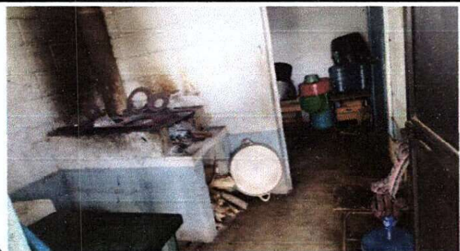
Foto1: MEJORAMIENTO DEL AREA DE COCINA
