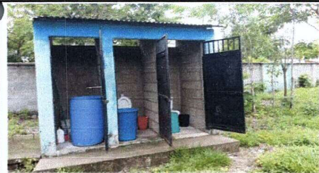
Foto 5: MEJORAMIENTO DE SERVICIOS SANITARIOS
