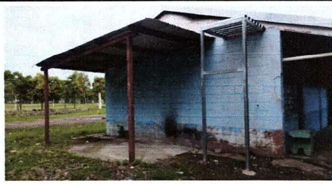
Foto 2: MEJORAMIENTO DEL AREA DE COCINA
