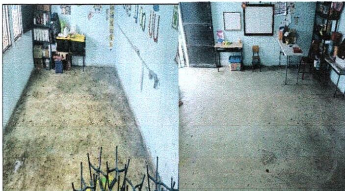
Foto 4: SUSTITUCIÓN DE PISO DE CONCRETO POR PISO CERÁMICO EN AULA
