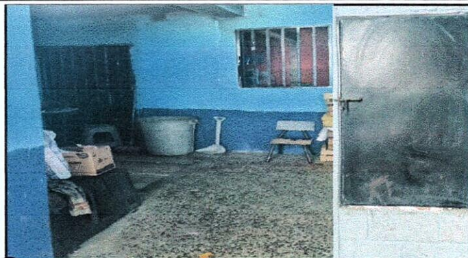
Foto 1: MEJORAMIENTO DE MURO DE BLOCK Y SUSTITUCIÓN DE VENTANA DE METAL POR VENTANA TIPO PERSIANA
