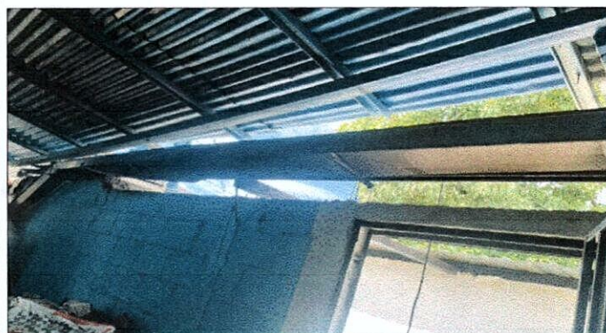
Foto 3: SUSTITUCIÓN DE LAMINA POR LÁMINA TROQUELADA CAL. 26 COCINA Y SUSTITUCIÓN DE CANAL METÁLICO EN COCINA
