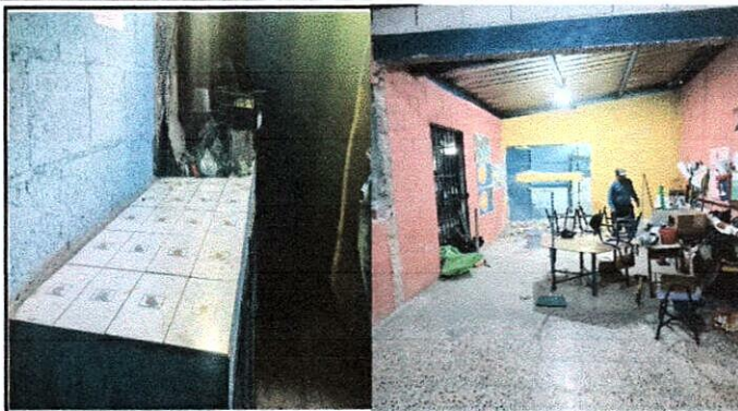
Foto 2: MEJORAMIENTO DE MESA DE CONCRETO Y SUSTITUCIÓN DE PISO DE CONCRETO POR PISO CERÁMICO
