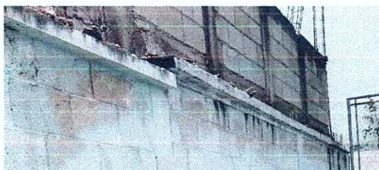
Foto 5: COLOCACION DE CANALES EN PAREDES
