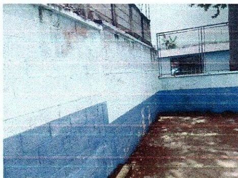
Foto1: MUROS DE DIFERENTES ALTURAS
