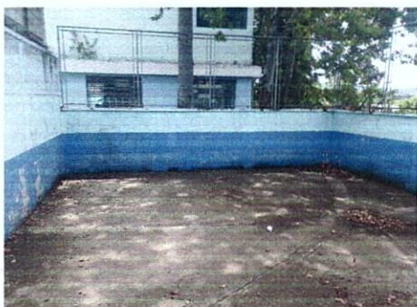
Foto 3: LEVANTADO DE PAREDES
