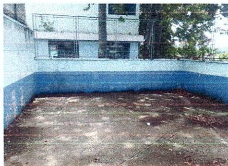
Foto 3: LEVANTADO DE PAREDES
