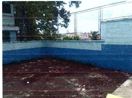
Foto 2: DESMONTAJE DE MALLA
