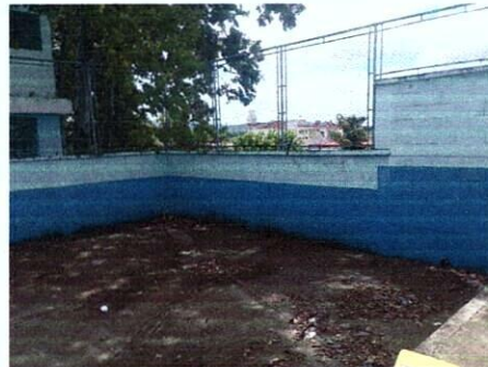
Foto 2: DESMONTAJE DE MALLA
