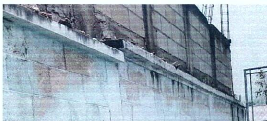
Foto 5: COLOCACION DE CANALES EN PAREDES
