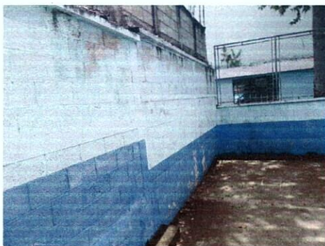
Foto1: MUROS DE DIFERENTES ALTURAS
