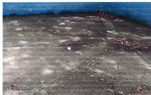
Foto 6: NIVELACION DE BASE
