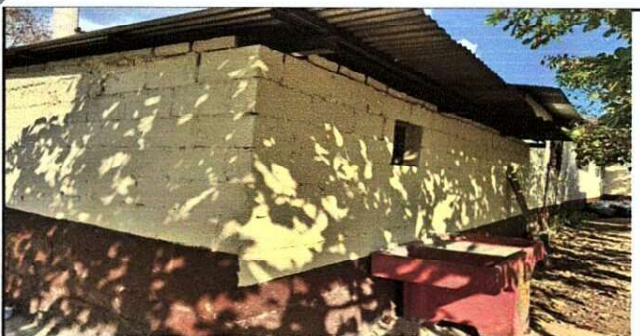
Foto 5: Se instalara ventanas de metal.
