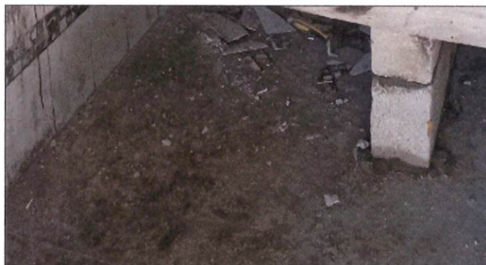
Foto 4: MEJORAMIENTO PISO EN COCINA, MEJORAMIENTO DE MUEBLE EN COCINA CON AZULEJO (TOP DE CONCRETO)
