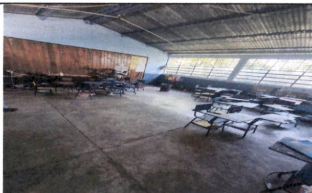
Foto 3: MEJORAMIENTO DE PISO EN MODULO (INCLUYE CONTRA PISO)
