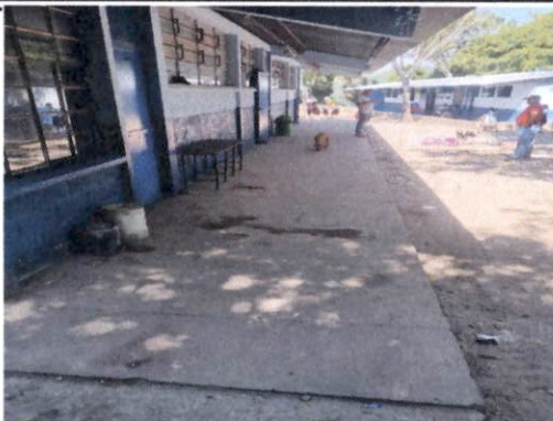
Foto1: MEJORAMIENTO DE NIVELACION, COMPACTACION Y RELLENO
