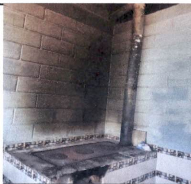
Foto 5: SUSTITUCIÓN DE ESTUFA RURAL COMPLETA (INCLUYE PLANCHA Y CHIMENEA)
