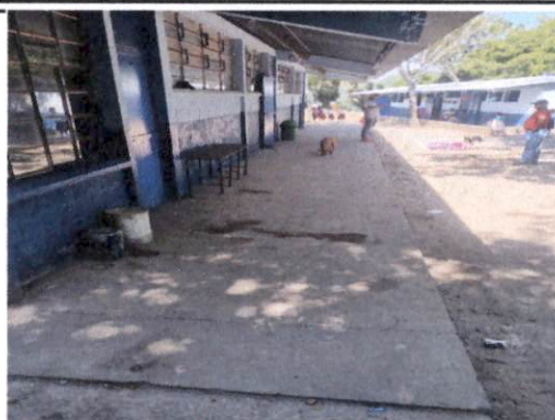
Foto 2: MEJORAMIENTO DE LOSA DE PATIO
