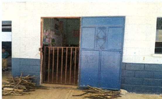
Foto 3: SUSTITUCIÓN DE PUERTA METÁLICA + CHAPA
