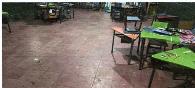
Foto 2: SUSTITUCIÓN DE PISO DE GRANITO POR PISO CERÁMICO EN MODULO DE AULAS
