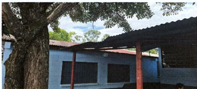
Foto1: SUSTITUCIÓN DE LAMINA POR LAMINA TROQUELADA CAL. 26 EN MODULO DE AULA
