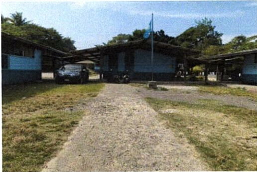
Foto 7: MEJORAMIENTO DE PISO DE TORTA DE CONCRETO EN PATIO DEL CENTRO EDUCATIVO.
