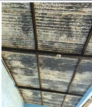
Foto 3: SUSTITUCIÓN DE TECHO DE LÁMINA ACANALADA CON ESTRUCTURA METÁLICA POR LÁMINA TROQUELADA DE ALUZINC CALIBRE 26, MANTENIMIENTO A ESTRUCTURA E INSTALACIÓN DE CAPOTE.
