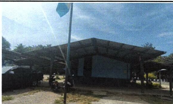
Foto 5: MEJORAMIENTO DE TECHO DE LÁMINA TROQUELADA DE ALUZINC CALIBRE 26 MÁS ESTRUCTURA METÁLICA.
