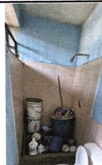
FOTO 12: Sustitución de mingitorio
