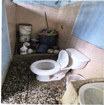
FOTO 13: Sustitución de Azulejo, Sanitarios
