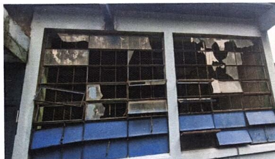
FOTO 8: Mantenimiento a estructura de de metal de ventana
