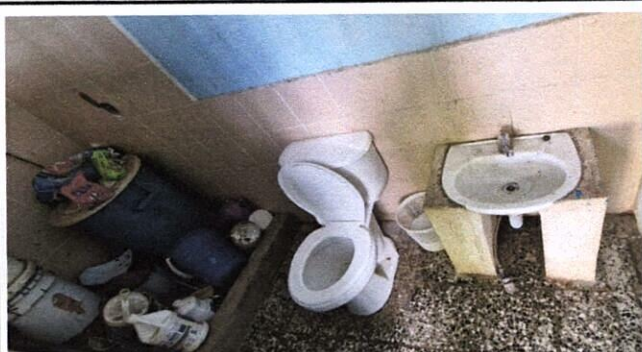
FOTO 9: Sustitución de piso ceramico
