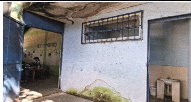
FOTO 6: Reparación de Pañuelos, paredes exteriores de sanitarios
