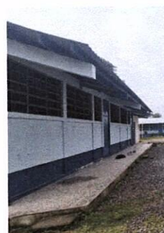
foto 10: Pintura en muros exteriores e interiores
