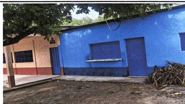
FOTO 4: Sustrucción de techo, con instalación de estructura metálica y lámina troquelada calibre 26, área de cocina
