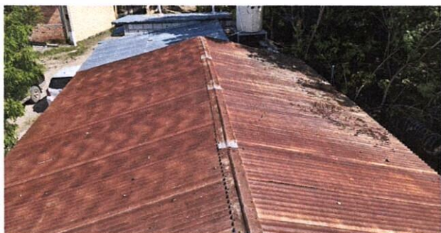
FOTO 1: Sustrucción de lámina, por lámina troquelada aluzinc calibre 26, en aula de párvulos
