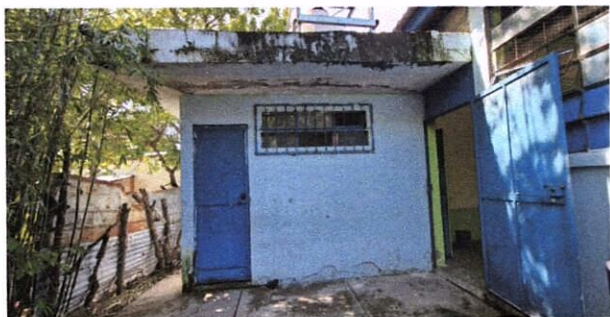
FOTO 7: Mantenimiento a estructura (lijado, cambio de tubo, cepillado, sujeciones, aplicación de pintura)
