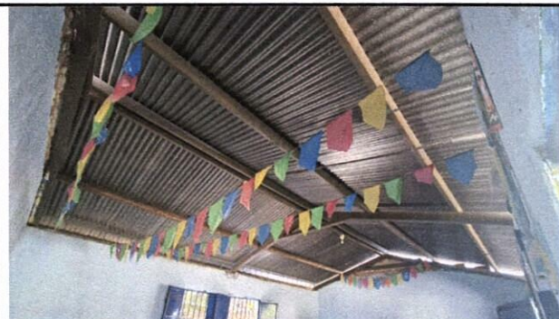
FOTO 2: Mantenimiento a estructura de soporte de metal, en aula de párvulos
