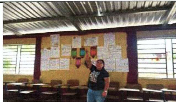
Foto 6: laminas en mal estado
