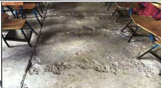
Foto 1: piso de torta de cemento
