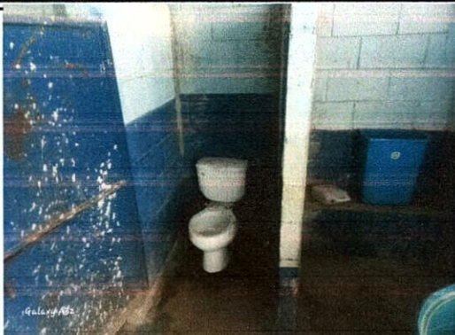
Foto1: Sustrucción de inodoros en mal estado
