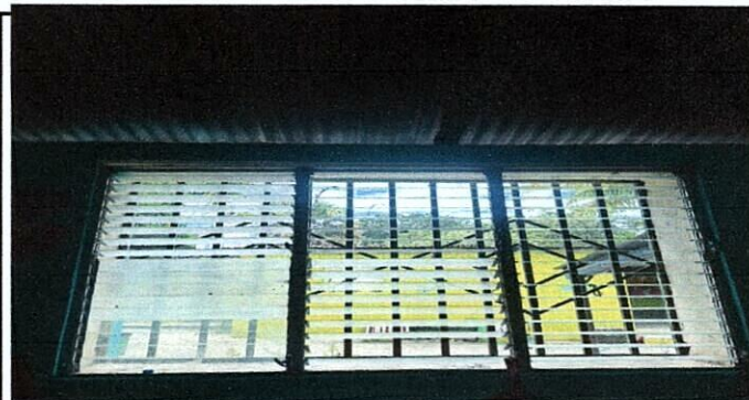
Foto 12: fabricacion e instalacion de ventana PVC No. 4 en aula No. 2
