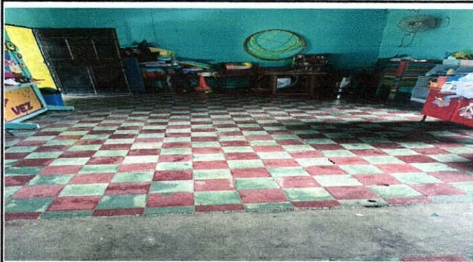
Foto7: instalacion y sustitucion de piso ceramico general en aula No.2
