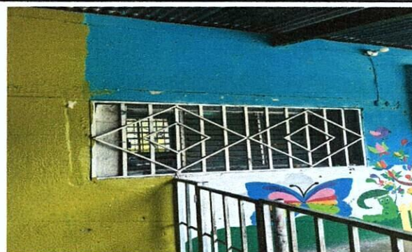
Foto 10. fabricacion e instalacion de ventana PVC No.2 en aula No.2
