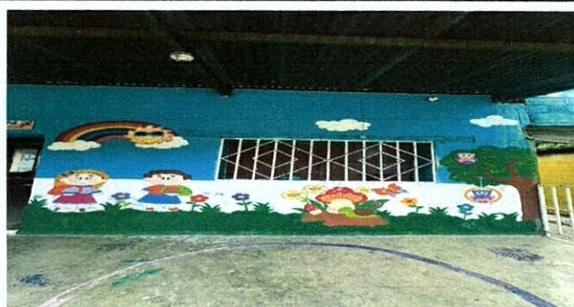
Foto 9: fabricacion e instalacion de ventana PVC No. 1 en aula No.2.
