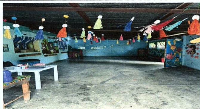
Foto1: Repello gris y blanco en toda el área interior del aula completa.
