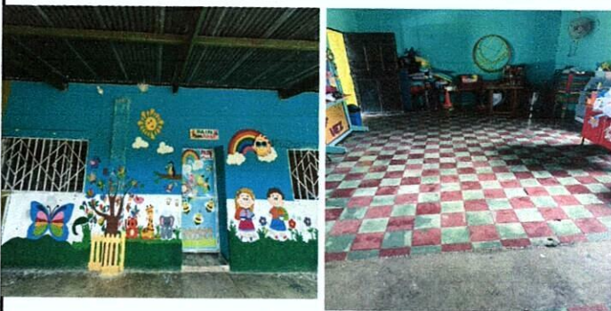
Foto 15: pintura genral en paredes interior y exterior en aula No.2.
