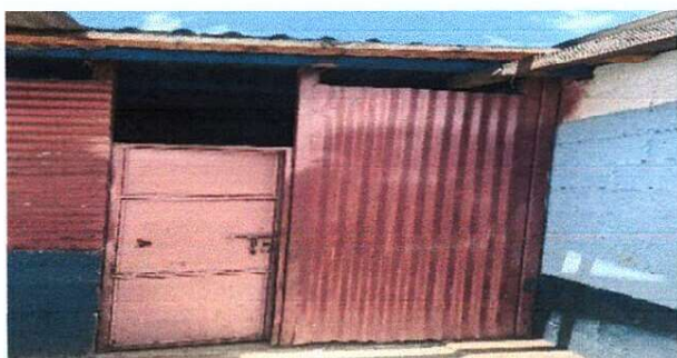
Foto 5: Sustitución de puerta de metal.
