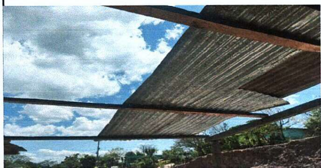
Foto1: Mejoramiento de techos
