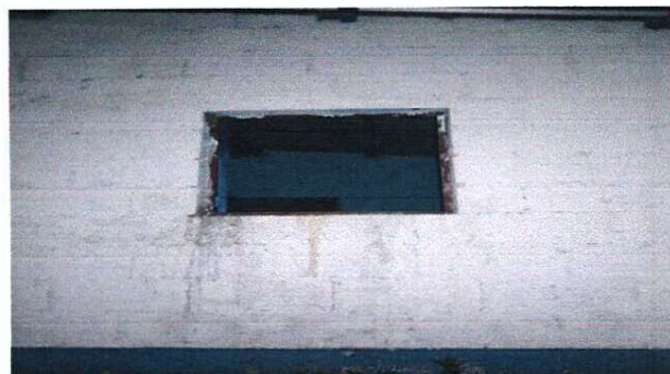
Foto 2: Mejoramiento de ventanas frontales
