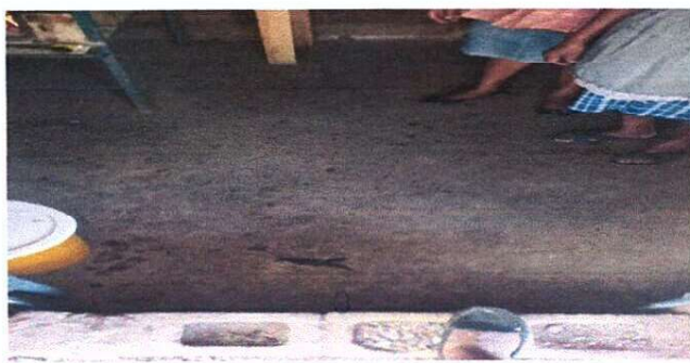
Foto 4: Impermeabilizacion de loza.
