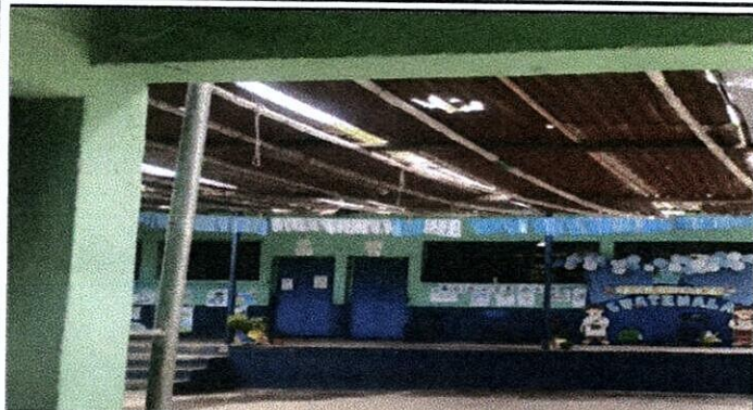
Foto1: SUSTITUCIÓN DE TECHO DE CORREDOR POR TECHO METÁLICO
