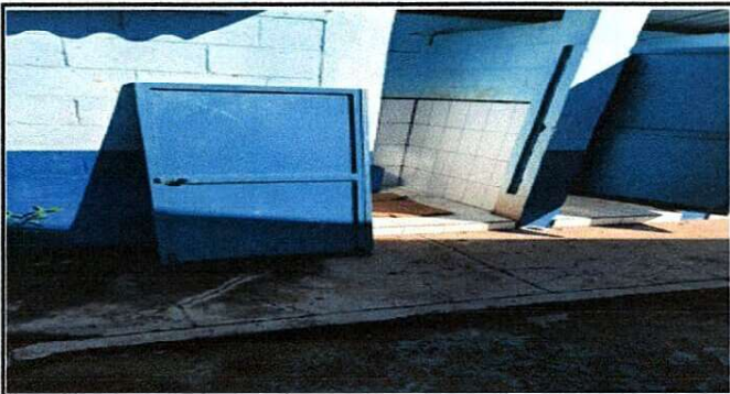
Foto 3: Mantenimiento a estructura de metal (lijado, cambio de tubo, cepillado, sujeciones, aplicación de pintura)
