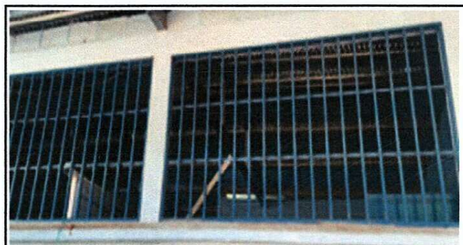
Foto 6: Mantenimiento a estructura de metal (lijado, cambio de tubo, cepillado, sujeciones, aplicación de pintura)
