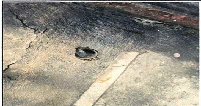
Foto 4: Reparación de torta de concreto
