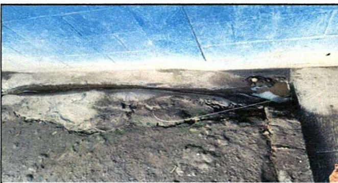
Foto 5: Reparación de cuneta de concreto
