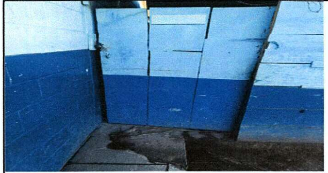
Foto 2: Puertas de metal
